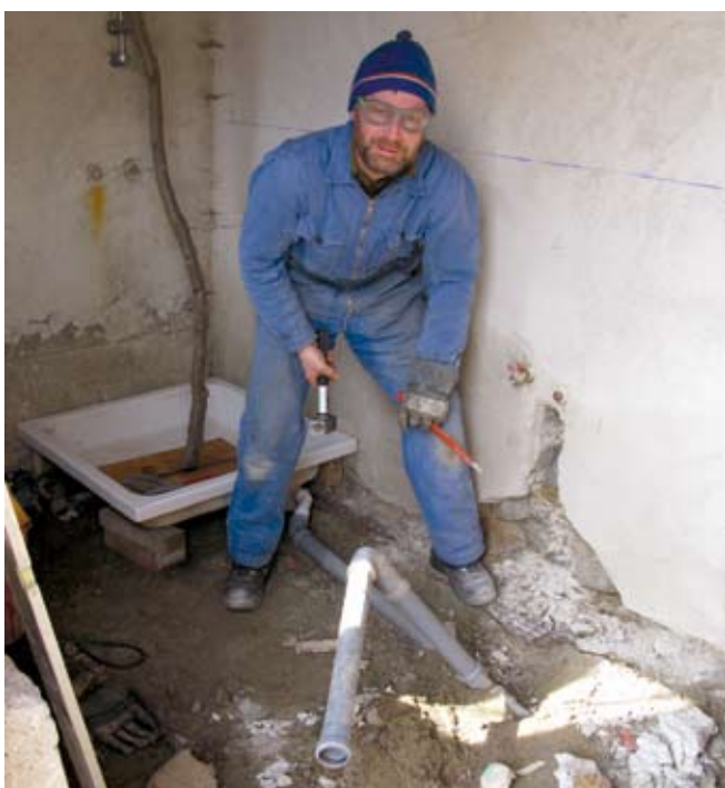
Markus Müller hat die Duschwanne gesetzt und bereitet jetzt die Abwasserleitung für das Lavabo vor.
