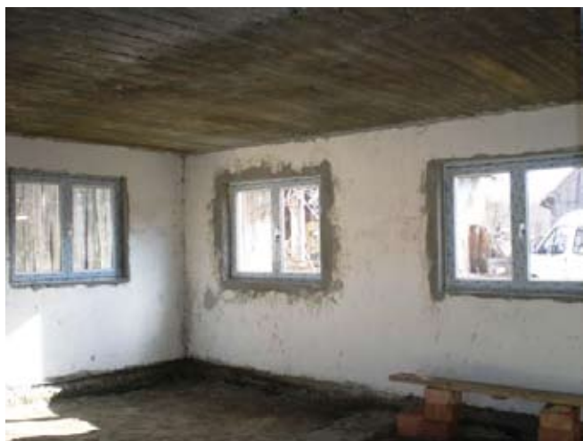
Die Fenster im Aufenthalts-/ Essraum.
