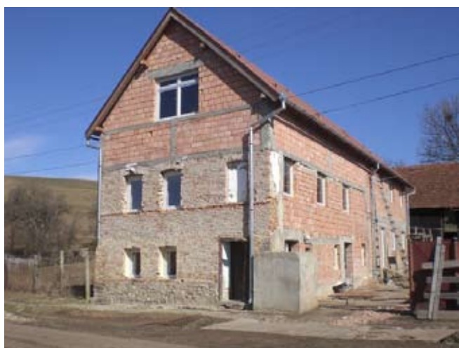
Alle Fenster sind fertig eingebaut.
